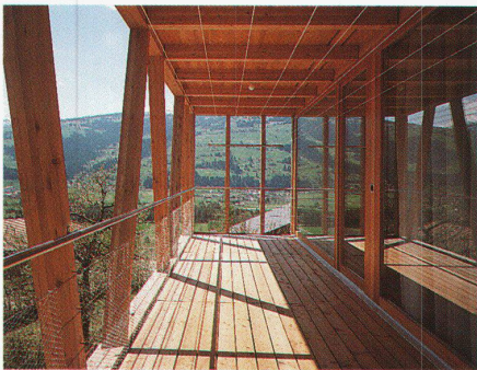
Südveranda ■ Véranda sud ■ South veranda
