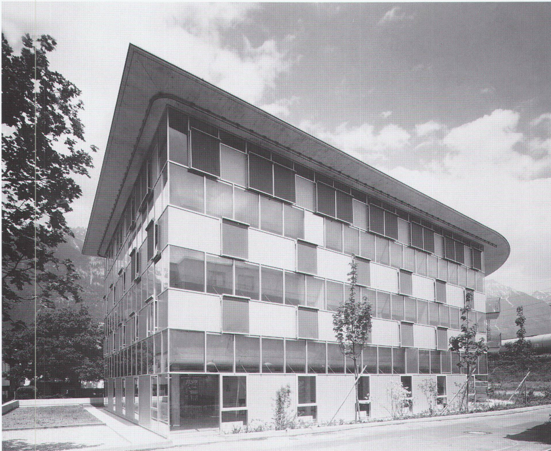
Gesamtansicht von Südosten
