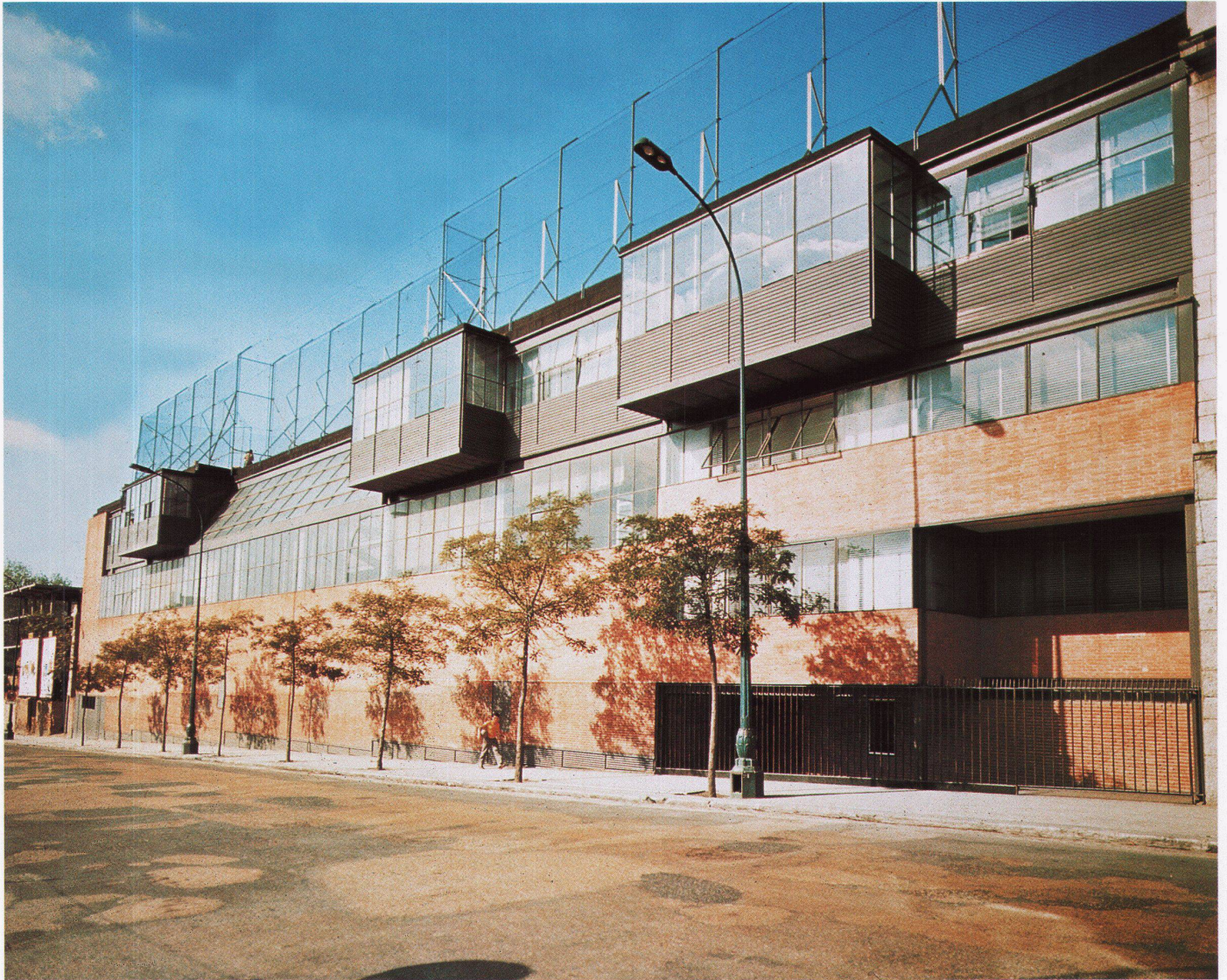
Blick von der Strasse ■ Vue de la rue ■ View from the road
