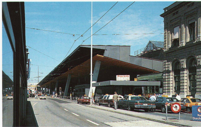
Bahnhofplatz: Hauptzugang und Taxivorfahrt ■ Place de la Gare: accès principal et stationnement taxis ■ Station Square: main entry and taxi area
