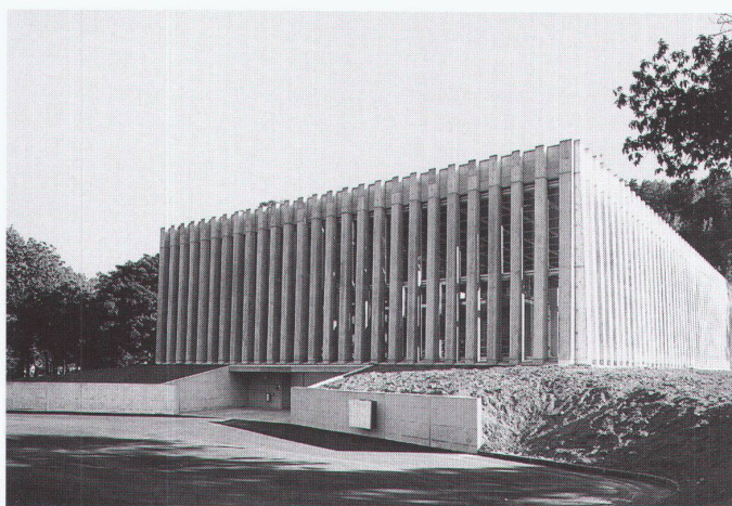
Mehrzweckhalle, Losone; Architekt: Livio Vacchini, Locarno
