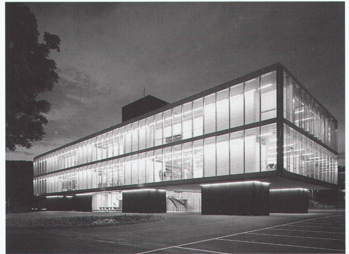
Ansicht von Südosten bei Nacht
