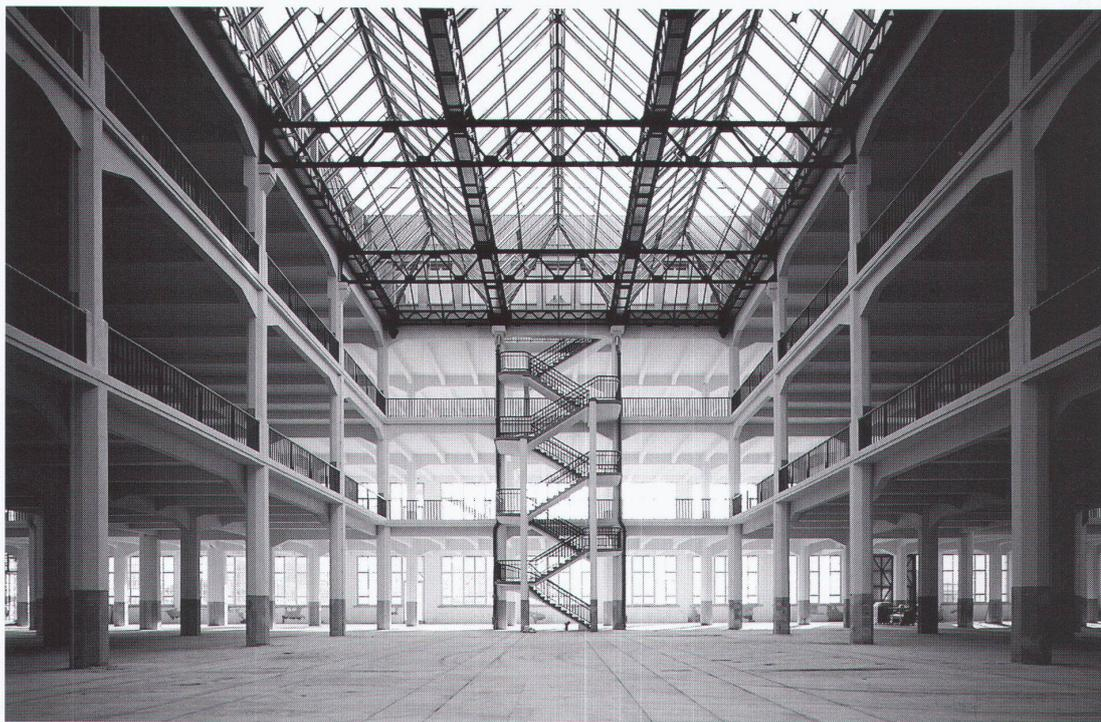
Die Rohbaustuktur des Stahlbetonskelettbau blieb erhalten wie die Abfolge von Lichthöfen. Die Einbauten erfolgten nach dem Prinzip der Trennung des Neuen vom Alten durch eine Verselbständigung der Einbauten.
