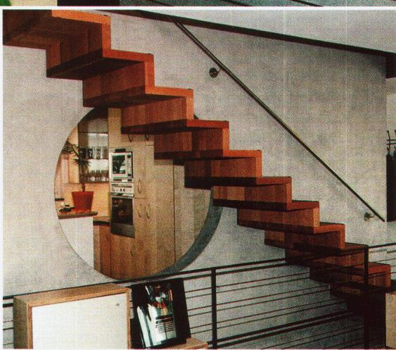
Die Firma Innenausbau Mäder AG hat eine Treppe entwickelt, die ohne abzustützen nur an die Wand befestigt wird.
