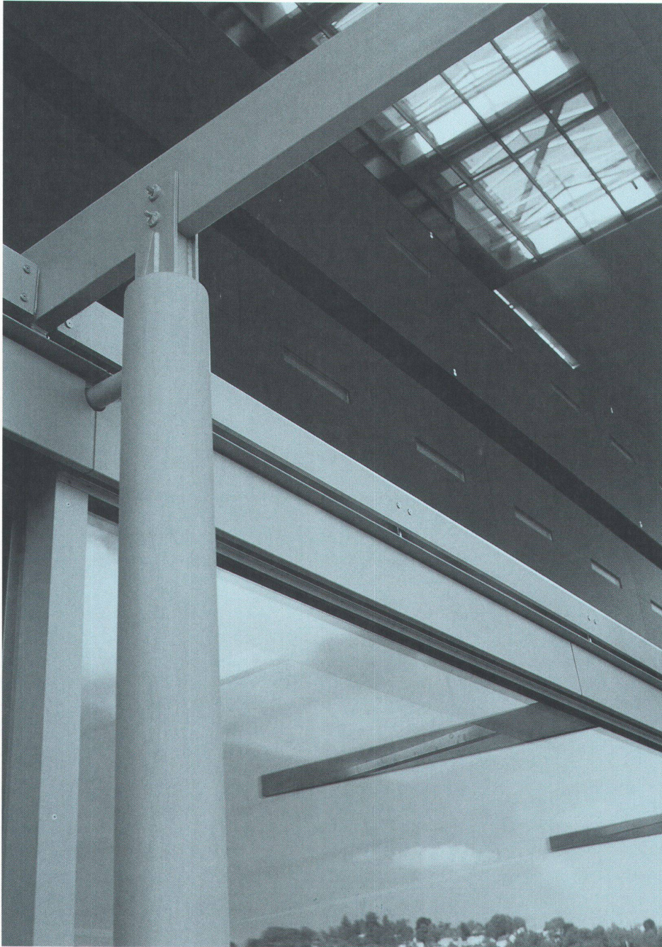
Kultur- und Kongresszentrum Luzern, Architekt: Jean Nouvel
