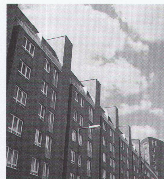
Josef Paul Kleihues: Wohnüberbauung Brunnenstrasse, Berlin Foto: Andreas Löhlein
