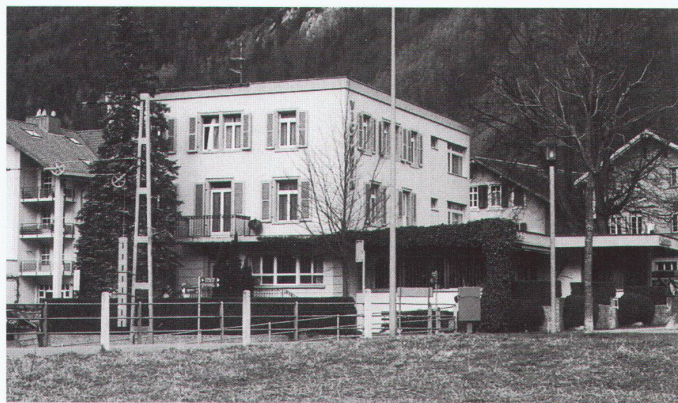
Zustand vor der Aufstockung (Umbau 1965, Ernst E. Andereg, Meiringen)
