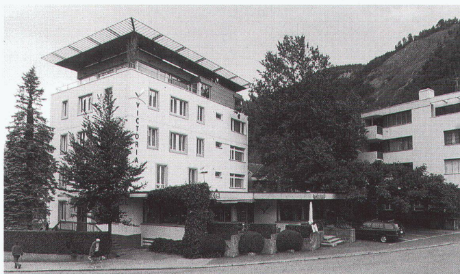
Umbau und Aufstockung, 1998–1999, E. E. Andereg + Partner, Meiringen
