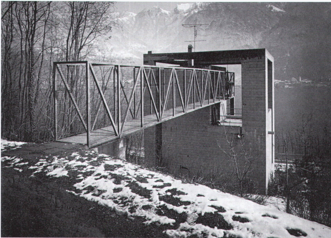
«Eisenbahnbrückenwohnhaus» Mario Botta: Haus in Riva San Vitale, 1971–1973. Aus: Emilio Pizzi: Mario Botta. Zürich, München: Artemis, 1991
