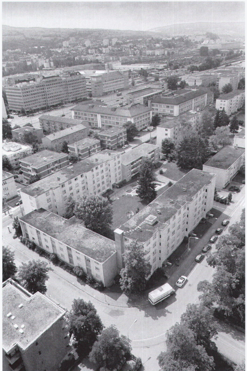
Blick auf die Siedlung Bernerstrasse im Grünaquartier, die im Rahmen der Aufwertung von Quartieren abgebrochen wird.
