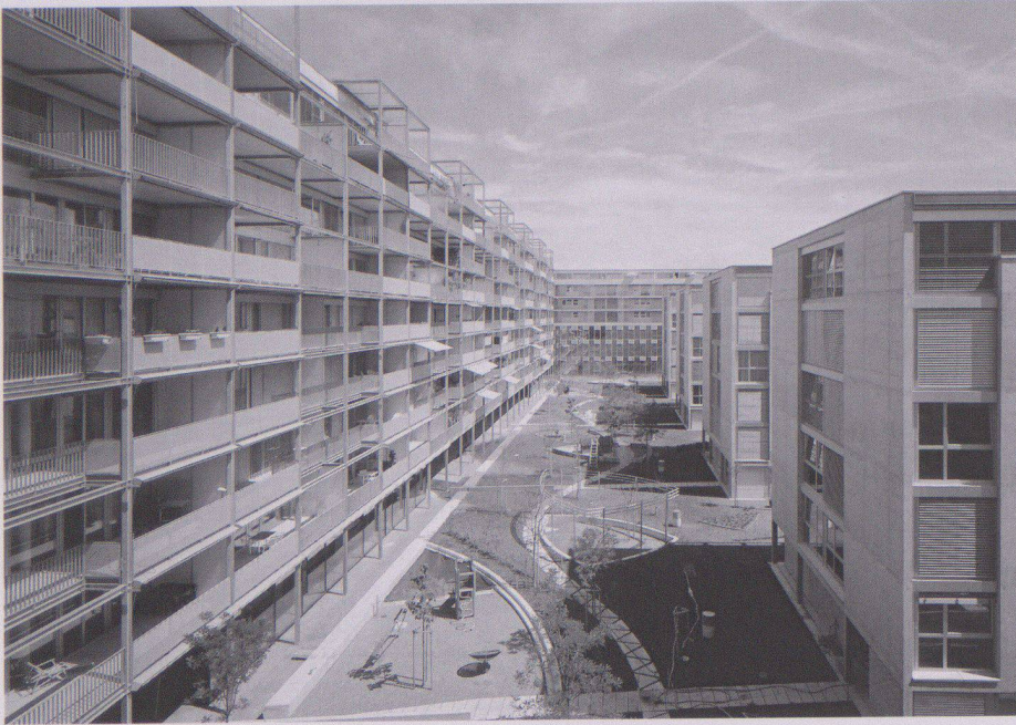
9 Blick von Nordwest über den Wohnpark
