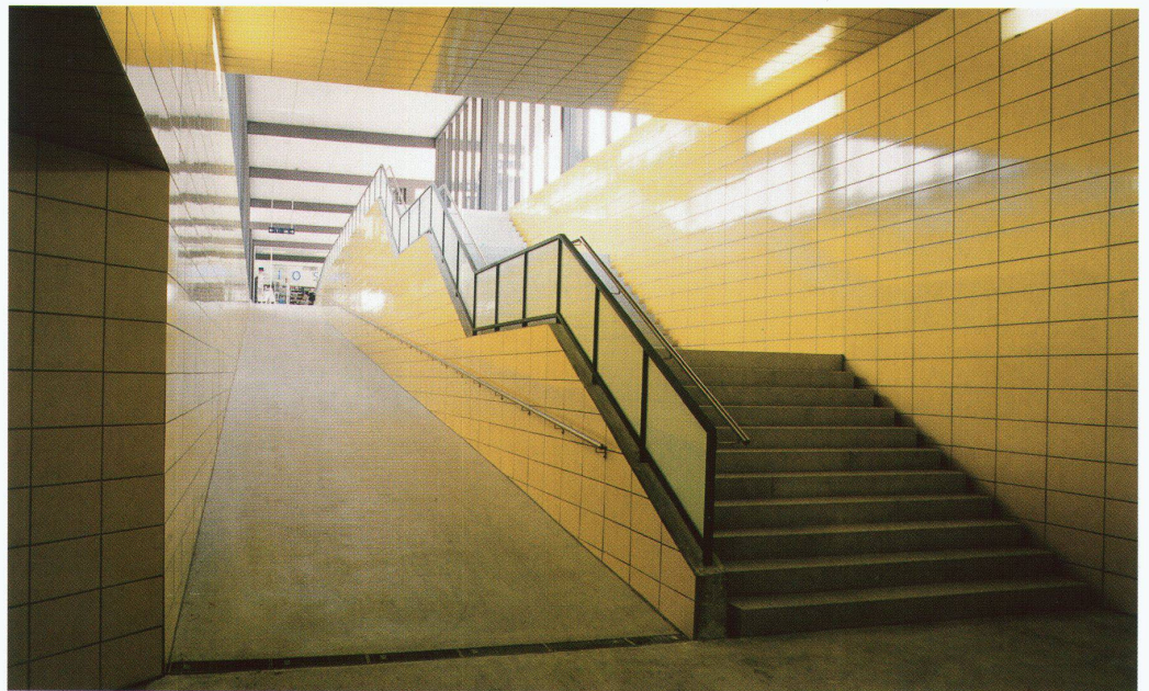
Hauptunterführung ▷ Sous-passage principal ▷ Main subway
