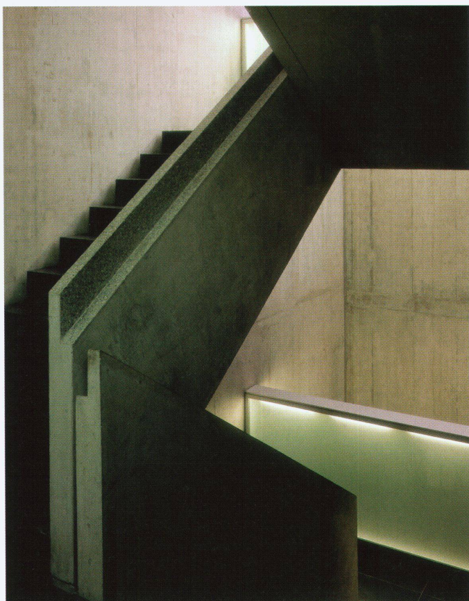
Vorgefertigte Treppe im massiven Kern
