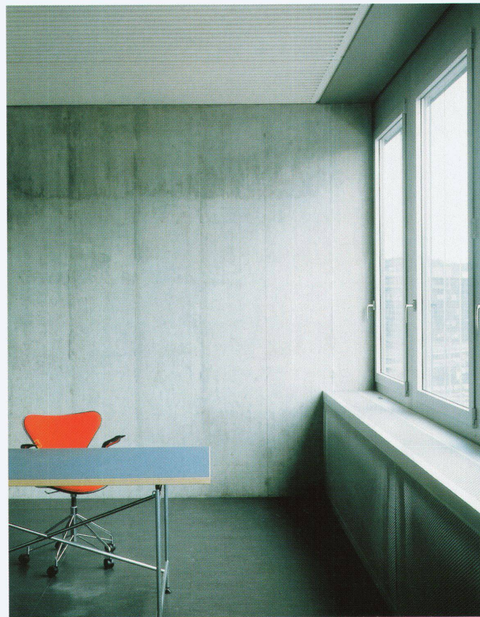
Büro mit Weisszement- Deckenelementen
