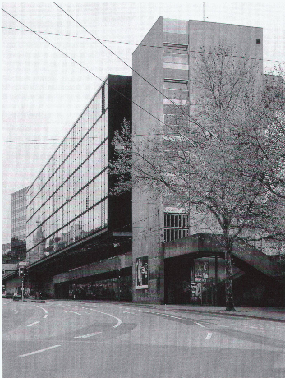
1 | Originalbau der Architekten Walter Schwaar und Philippe Bridel, Ansicht Nord (Foto: Ende 50er-Jahre)
