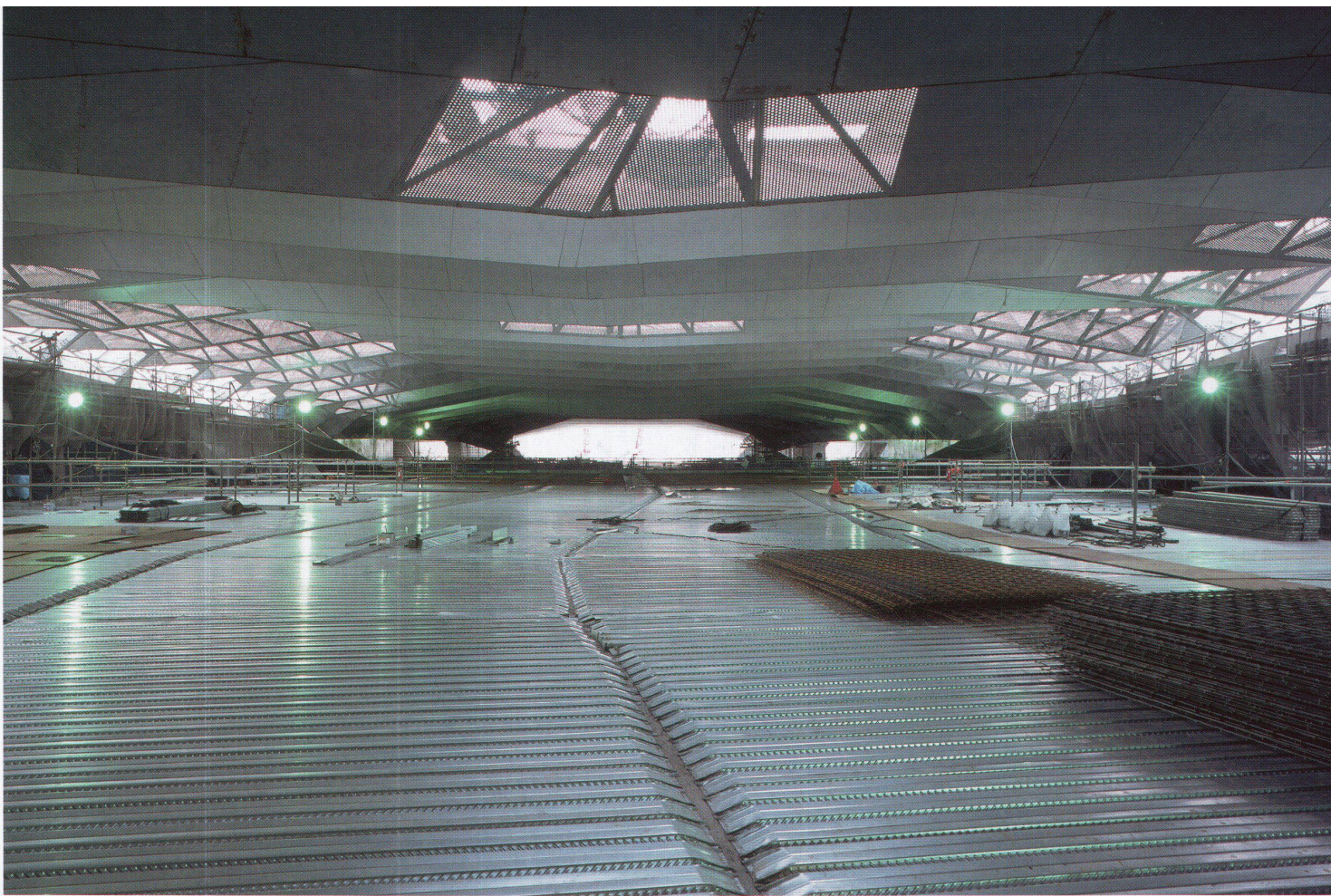
Abfertigungshalle im Bau
