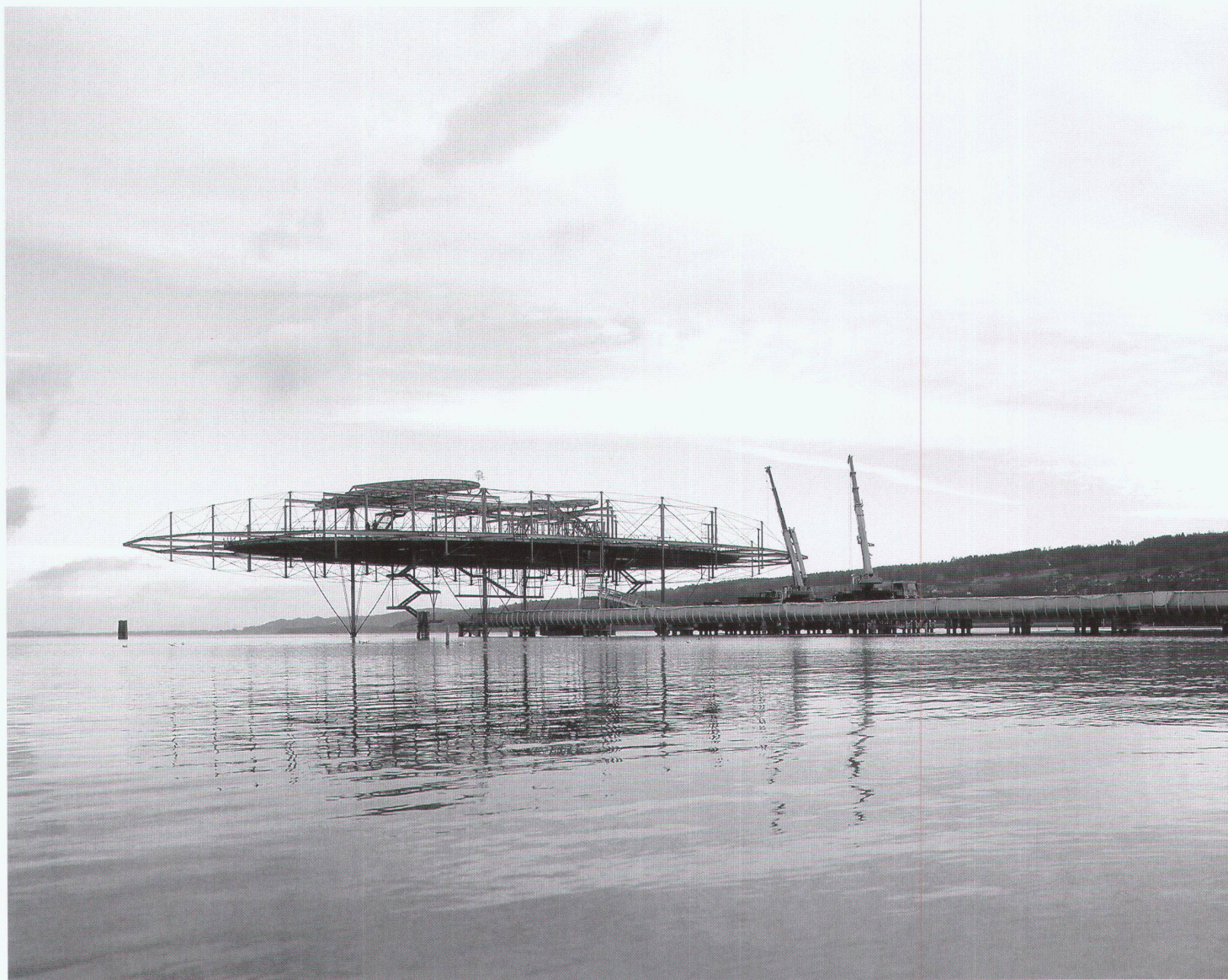
Arteplage Yverdon-les-Bains, Struktur der Wolke, im Bau
