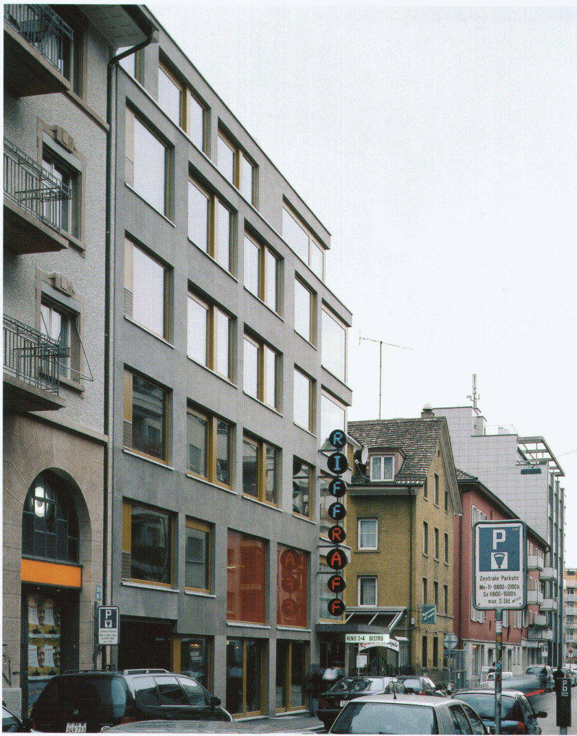
Ansicht von der Neugasse
