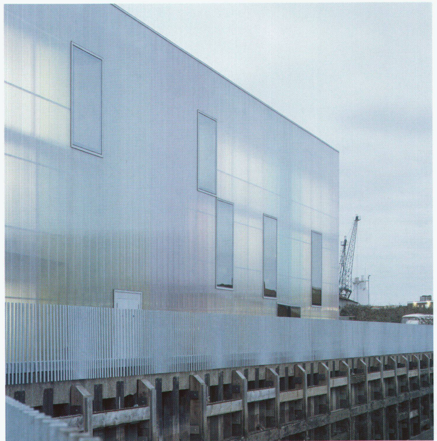
... durchlässig in der Dämmerung. – Bild: Dennis Gilbert
