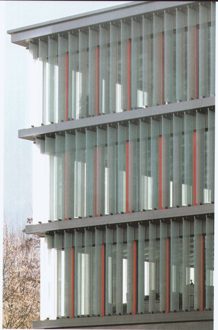
Verwaltungsgebäude der Würth Holding in Chur. – Bild: Ralph Feiner
