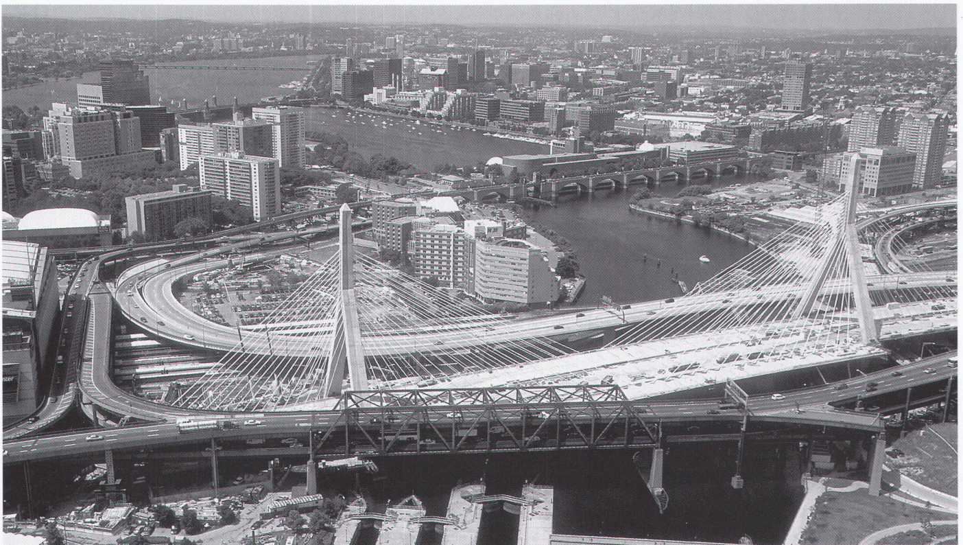
2002: bis zur Fertigstellung der Zakim Bridge bleibt die doppelstöckige Autobahnbrücke von 1959 in Betrieb. Dies verunmöglichte eine durchgängig seitliche Anordnung der Kabel. Oberhalb der Zakim Bridge der Leverett-Zubringer, im Hintergrund das Charles River Becken mit den Esplanaden von Boston und Cambridge.
