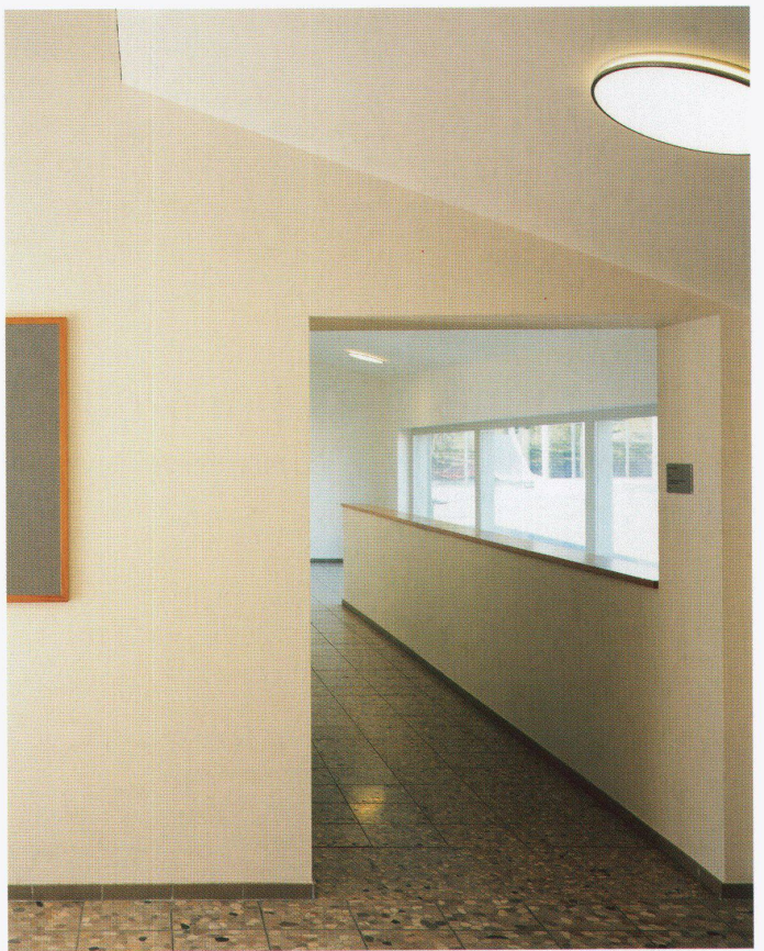
Blick von der «alten» Eingangs- in die neue Treppenhalle
