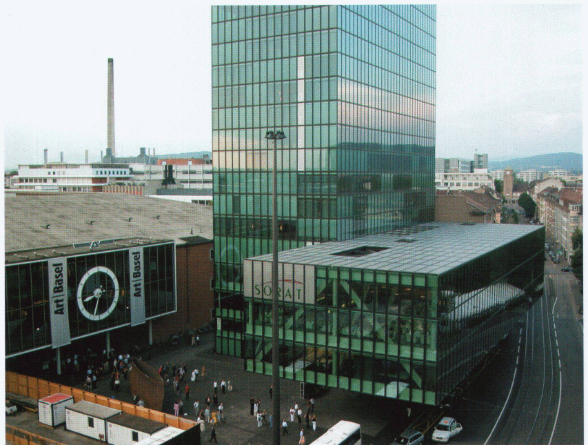
Abschluss für den Messeplatz: Blick Richtung Badischer Bahnhof
