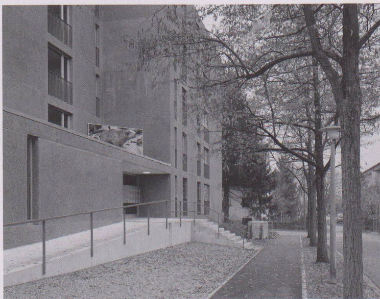
Bilder: Georg Aerni, von Ballmoos Krucker (Baustellenfotos)
