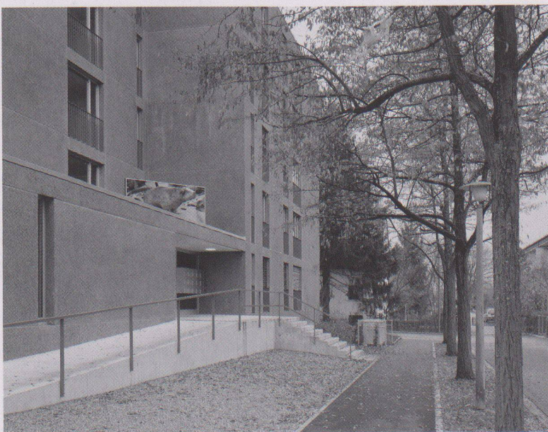
Bilder: Georg Aerni, von Ballmoos Krucker (Baustellenfotos)
