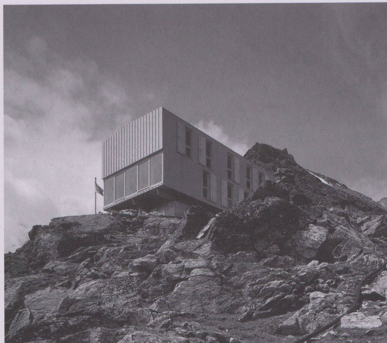
Bilder: Claudio Merlini, Jean-François Kälin (Baustelle)
