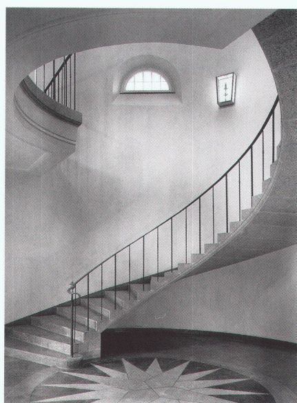
Dresdner Bank «Königin-Olga-Bau», Stuttgart, 1949–55. Treppenhaus.
