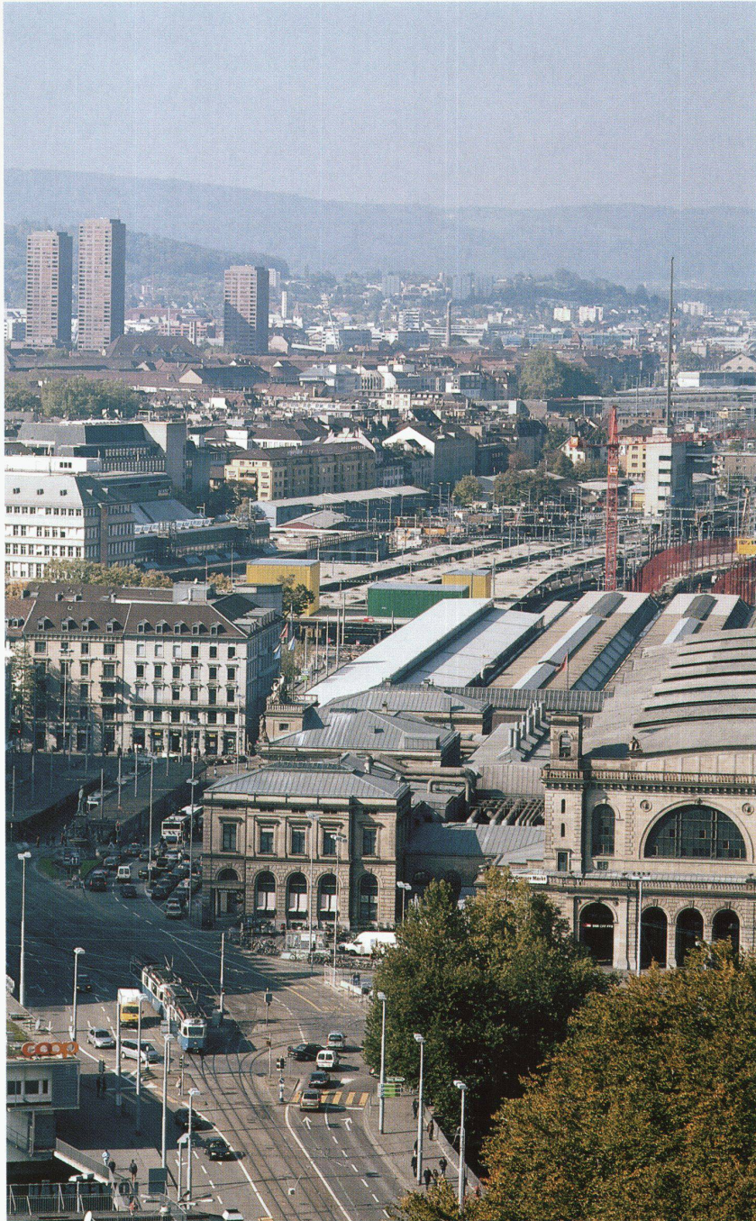
Hauptbahnhof Zürich mit Halle, Perronanlage und provisorischem S-Bahnhof Sihlpost
