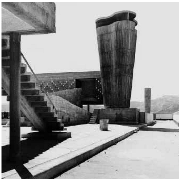
Dachlandschaft der Unité d'habitation in Marseille, 1946–1952
