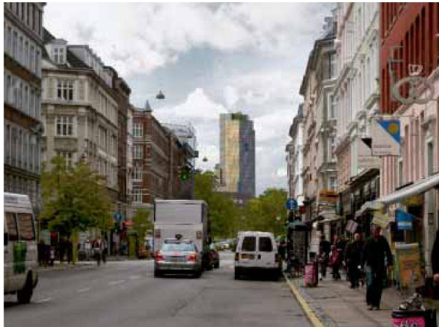
Projekt für die Umnutzung des Brauereigeländes Carlsberg im Zentrum Kopenhagens, städtebaulicher Wettbewerb 2007. – Bild: Carlsberg, Kopenhagen
