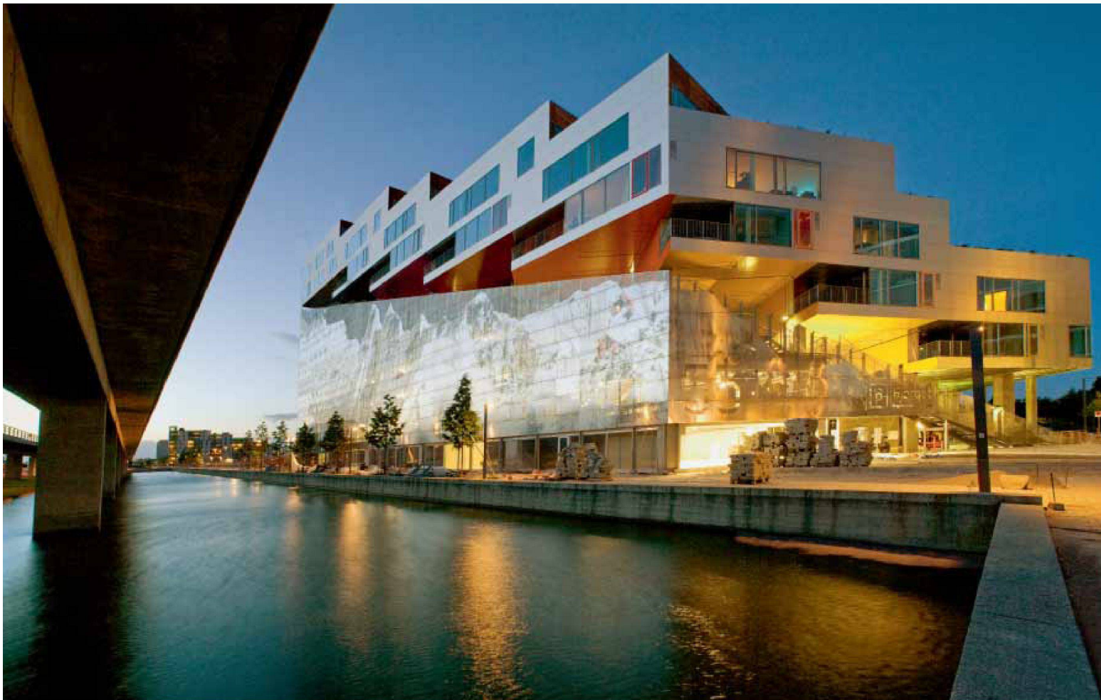
Pixelierte Aufnahme der Mount Everest-Bergkette als Fassade der Parkinggarage, links im Bild die Metro durch Ørestad. – Bilder: Jens M Lindhe
