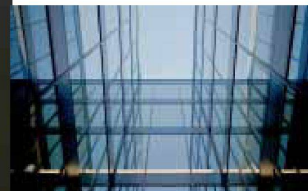
Hartmann setzt visionäre Architektur um: Fassadenbau
