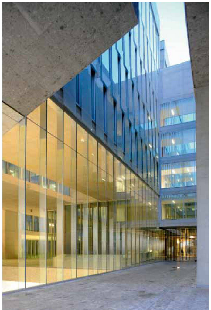
Eingesetzte und abgehängte Glasfüllungen
