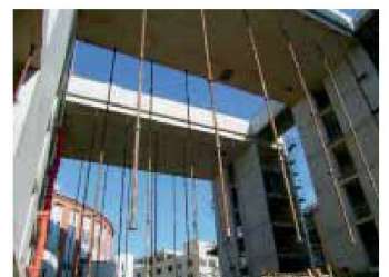
oben: Modell der Università Bocconi Mitte und unten: Tragstrukturen im Bau
