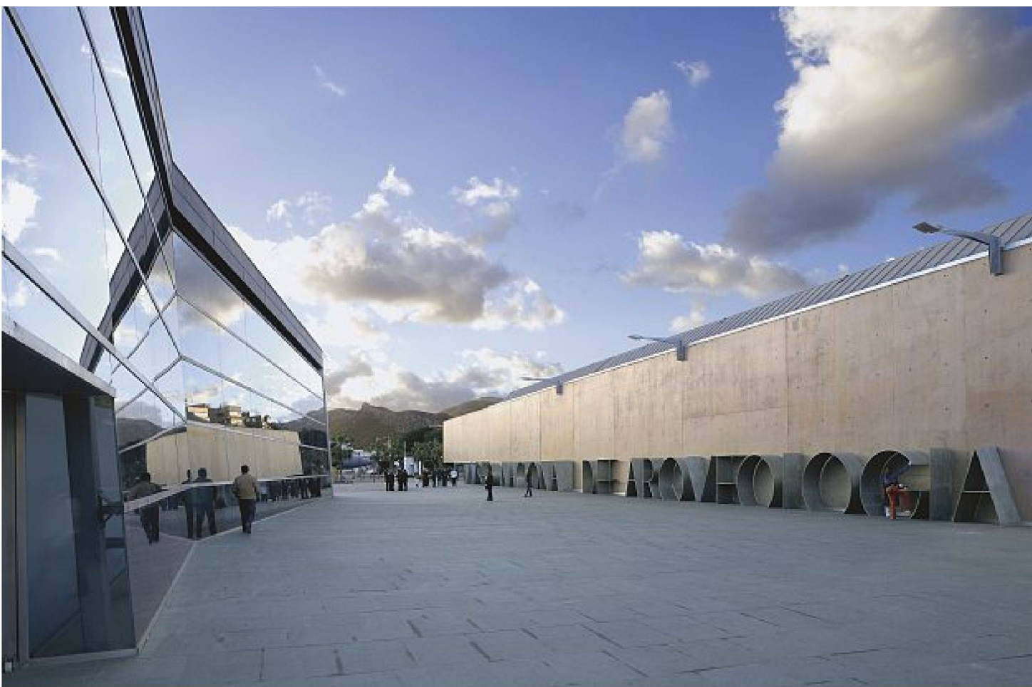
Der Platz zwischen den beiden Baukörpern bildet einen neuen Raum auf der Hafemole
