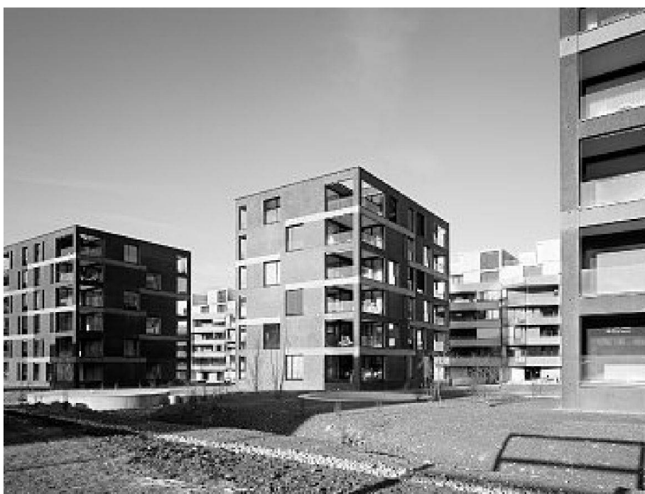
Punkthäuser, im Hintergrund das Langhaus
