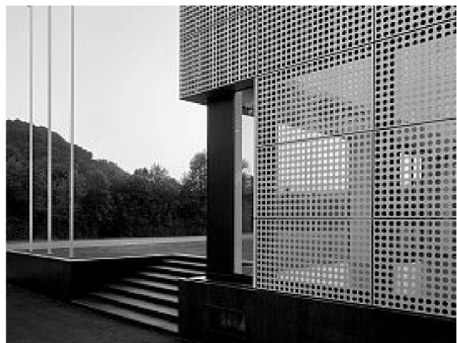
Eloxierte Lochbleche bilden die dünne Fassadenhaut.
