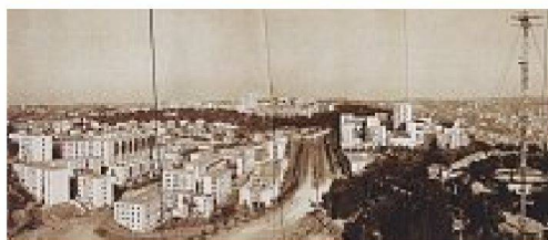
Siedlung Diar-El-Mahçoul, Archivaufnahme: links die cité «simple confort», im Vordergrund rechts die cité «confort normal», im Hintergrund in der Mitte die Siedlung Diar-Es-Saada. – Bild aus: Jean-Lucien Bonillo (éd.), Fernand Pouillon, Marseille 2001.
