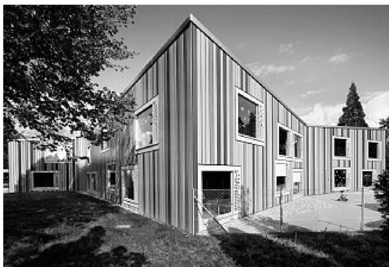
Garderie et parc
