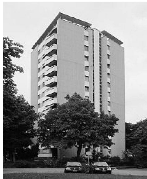
Vor dem Umbau. – Bild: Burkhalter Sumi Architekten
