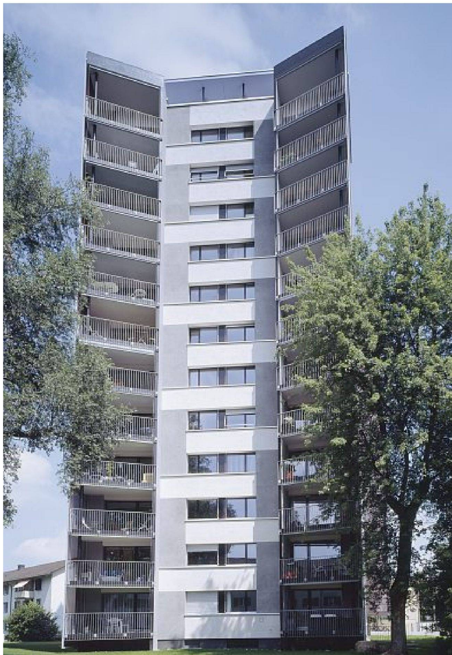
Südfassade mit neuen Balkonen für die umgebauten Wohnungen
