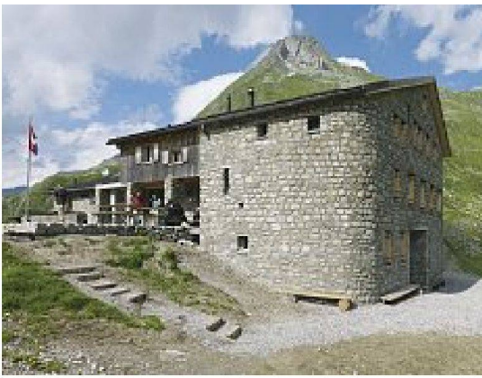
Gebäudeschichten: rechts die jüngste Erweiterung
