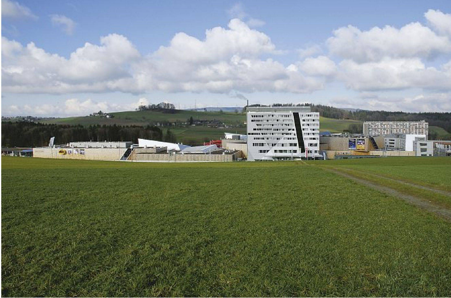
Gesamtansicht von Süden
