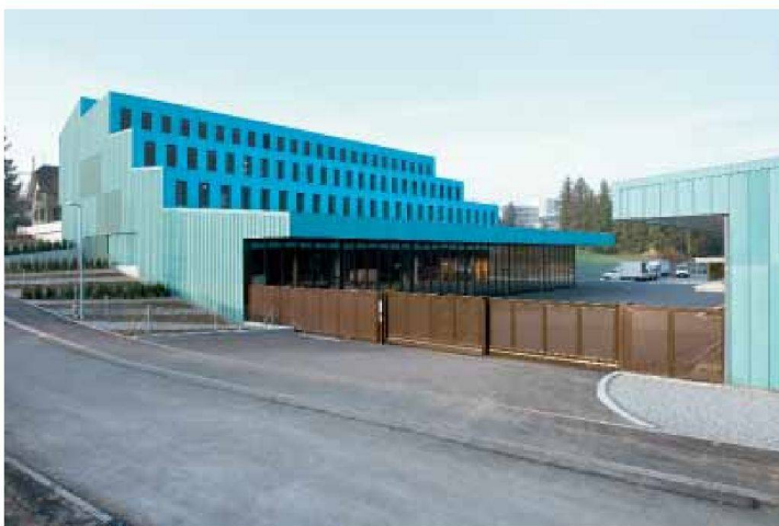
Betriebsgebäude IBB, Brugg
