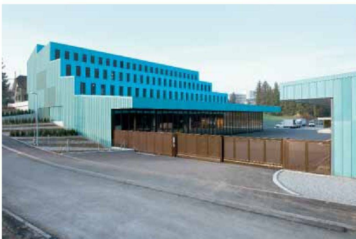
Betriebsgebäude IBB, Brugg
