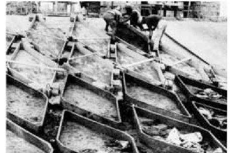
Unten: Einstellhalle für Landwirtschaftsmaschinen in Torre in Pietra, Rom (1945): Die Drahtzementformen des Dach-Tragwerks werden zur Überprüfung der Geometrie neben der Baustelle auf eine aufgeworfene Negativform aus Erde gelegt.
