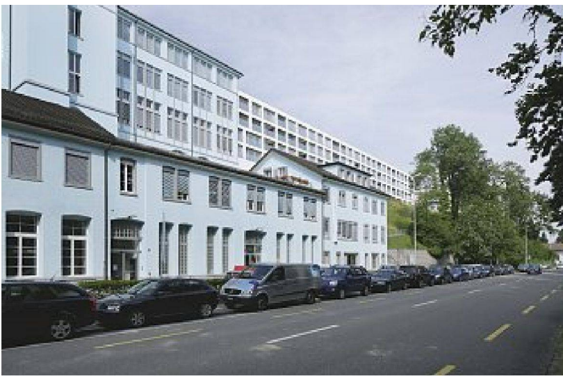
Wohnüberbauung Zentrum Farb, Haus 1, Thalwil; Bauherrschaft: Weidmann Management AG, Thalwil; Architektur: Gigon/Guyer, Zürich; Wettbewerb 1998, Planung/Ausführung 2005–2008. – Bilder: Lucas Peters
