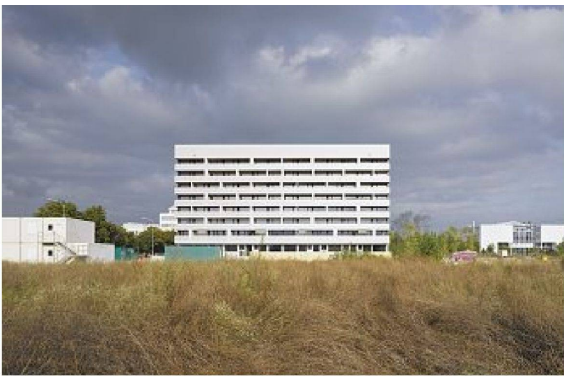
Wohn- und Geschäftshaus Baufeld A4, Färbi-Areal, Schlieren; Investor: Immobiliengesellschaft IMMOSIP AG, Zürich und Halter AG Generalunternehmung, Zürich; Architektur: Galli Rudolf Architekten, Zürich; Städtebauliches Gesamtkonzept 2003, Gestaltungsplan 2005, Planung/Ausführung 2006–2009 (S.15 Gebäude rechts: novaron Architektur) Bilder: Hannes Henz
