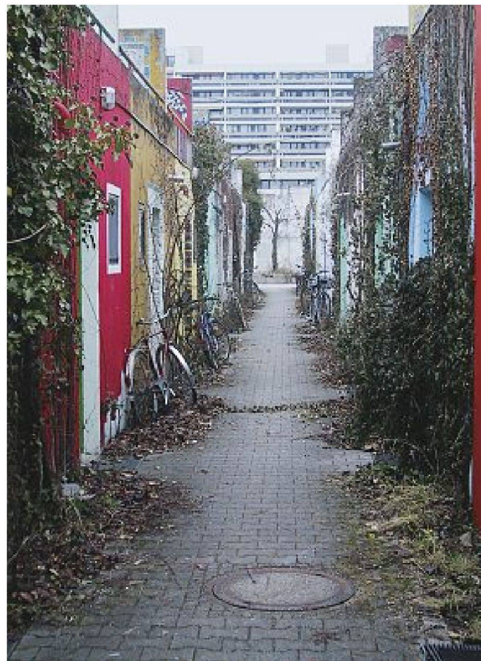
Flachdachbauten vor der Erneuerung, Aufnahmen 2006. – Bilder: bogevichs buero
