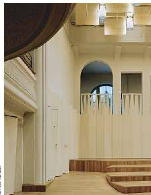
Diffraktor aus mit Gold belegten Sperrholzplatten (oben) und Täfelung zur Vermeidung von Flatterechos beim Bühnenbereich
