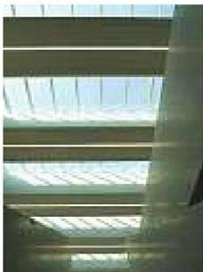
die eine Pfosten-Riegelkonstruktion für grossflächige Schräg- und Dachverglasungen trägt. Dieses System ermöglicht eine zuverlässige Dichtung bei kontrollierter Belüftung und Entwässerung an den Glasfalten. Weil die Zargen auf die äusseren Ränder der Betonbrüstungen gesetzt sind, ist die Rahmenkonstruktion von innen praktisch unsichtbar. Die Lüftungsflügel sind in das Rahmensystem der Oberlichter integriert, ihre Antriebe verdeckt eingebaut.
