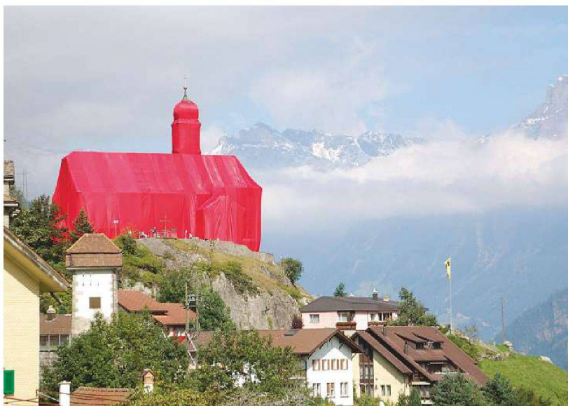
Wassen mit eingehüllter Kirche aus Anlass der 125-Jahr-Feier der Gotthardbahn. Die ständige Wohnbevölkerung nimmt kontinuierlich ab, die alten Häuser ziehen eine neue Schicht multilokaler Bewohner an. – Bild: David Mauro
